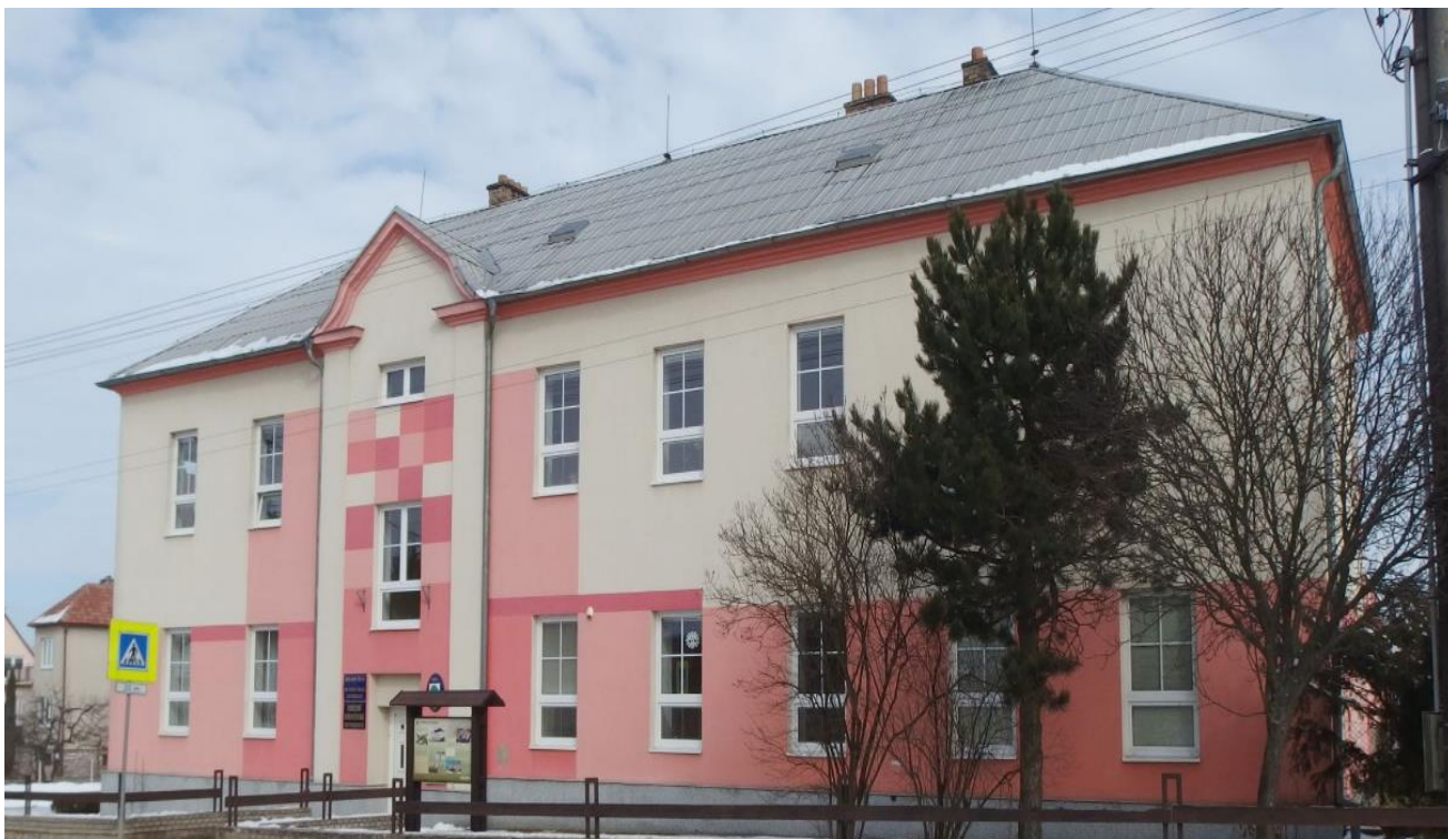
Obrázek 17: Budova Základní a mateřské školy 22
